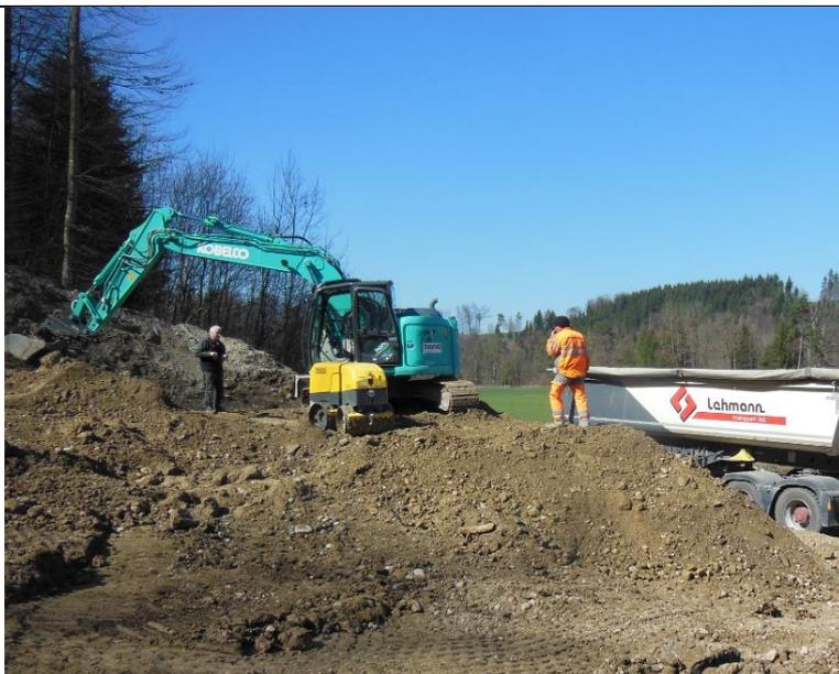
Aufschüttmaterial wird hergebracht, mit dem Bagger eingebaut und mit dem Ramax verdichtet und verfestigt.
