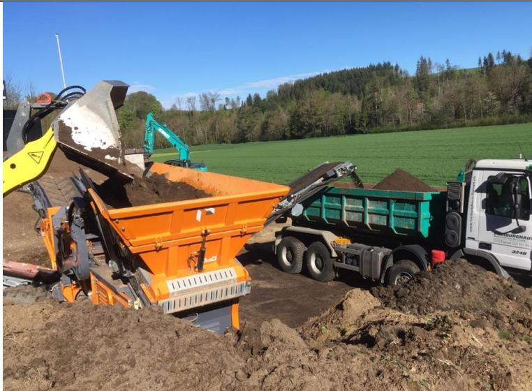
Aufbereitung und Einbau von steinfreiem Material im oberen Dammbereich gemäss Vorgaben Weisungen für Schiessanlagen
