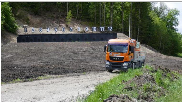
Am 29. Mai 2019 wurde der Kugelfangdamm und der Vordamm mit Hydrosaat behandelt zur Befestigung und Stabilisierung des Erdreichs.
